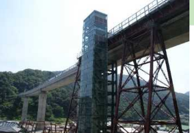
余部鉄橋及びクリスタルタワー
