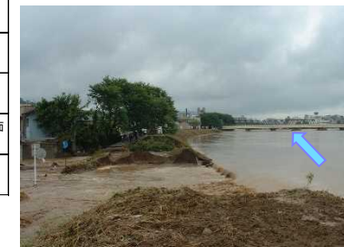
平成16年7月洪水(福井豪雨) 破堤地点(福井市春日)の越流状況
