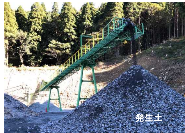
トンネル掘削土を路体盛土材に活用
