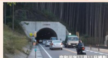
国道480号鍋谷峠トンネル(和泉市父鬼)
