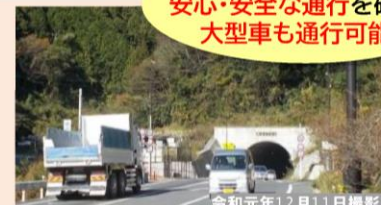
国道480号鍋谷峠トンネル(かつらぎ町平)
