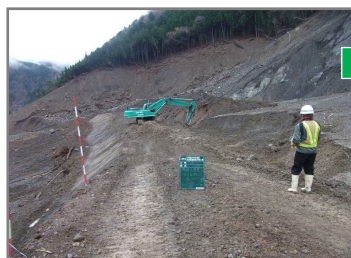
2011年 目視遠隔操作で土堤設置
