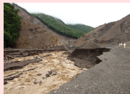
降雨後の下流河道の状況
