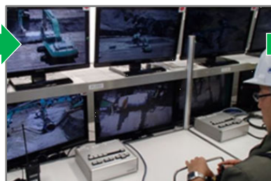
2015年 モニタ遠隔操作で排水管設置
