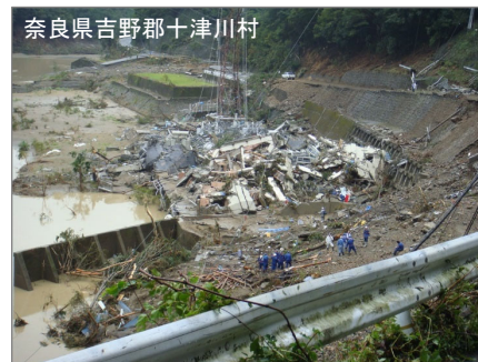
紀伊半島大水害 土石流被害の状況 (長殿発電所被災)
