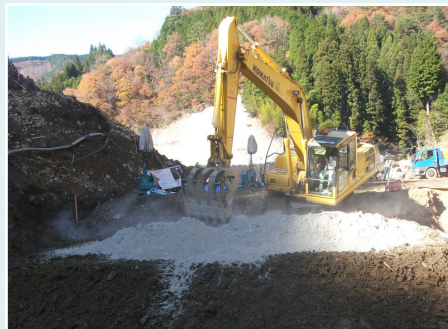
固化剤散布・混合
