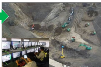
2020年 15台同時遠隔操作で掘削・土砂運搬
