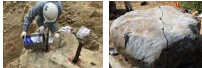
※写真のように薬液を注入し亀裂を発生させることで、振動無く破碎できる。
