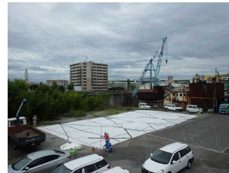
汚濁防止膜(令和2年7月撮影)
