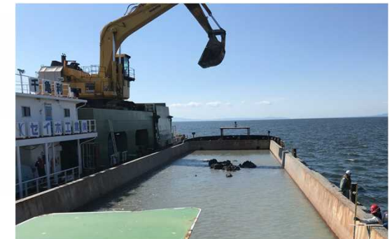
トレミー砂撒船での浚渫土砂投入状況(令和2年8月撮影)
