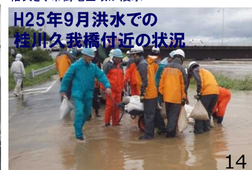
H25年9月洪水での 桂川久我橋付近の状況 京都市久我地区で、堤防からの越水が発生。水防活動により堤防決壊を防いだ
