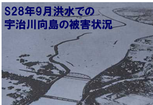
S28年9月洪水での 宇治川向島の被害状況 宇治川左岸向島堤及び右岸支川芥川、桧尾川等 が破堤
