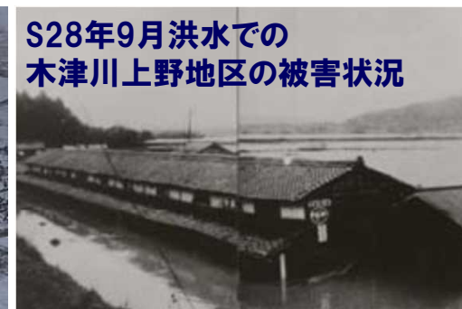
S28年9月洪水での 木津川上野地区の被害状況 上野地区及び名張地区で甚大な被害が発生
