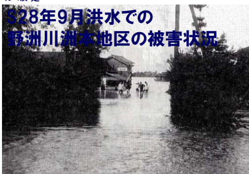
S28年9月洪水での 野洲川洲本地区の被害状況 野洲川南流左岸堤防の決壊により、流出全壊半壊 家屋1,700戸、死者3名の被害
