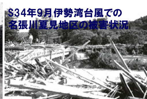
S34年9月伊勢湾台風での 名張川夏見地区の被害状況 名張地区で数力所の決壊氾濫が発生。橋の流出が 相次ぎ、市街地全域が浸水
