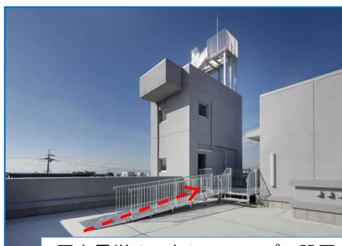
屋上見学ルートにスロープの設置
