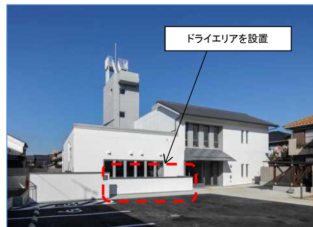
地下への機器搬出入用にドライエリアを設置 (将来の機器更新時に搬出入が容易になるよう配慮)
