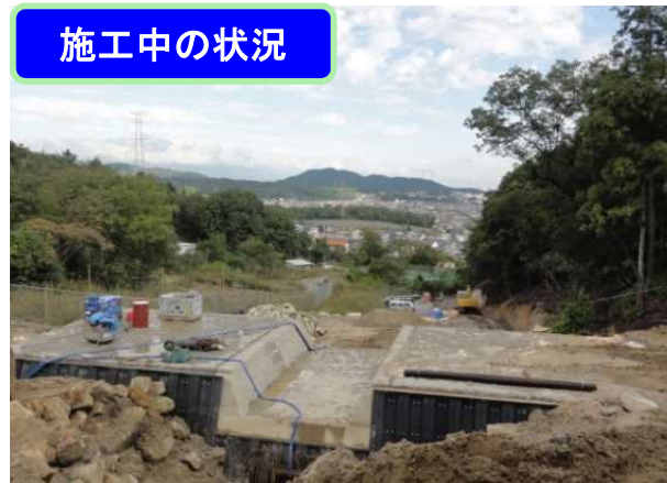
【砂防ソイルセメント工法による施工】
