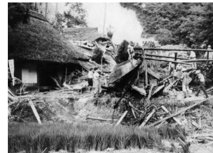
【昭和28年 信楽町多羅尾豪雨による土砂災害】 裏山の崩落による埋没した家屋
