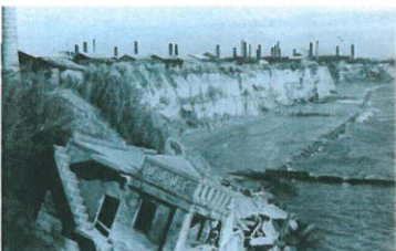
昭和39年頃に侵食によって崩落したタコ壺工場（江井ヶ島地先）
