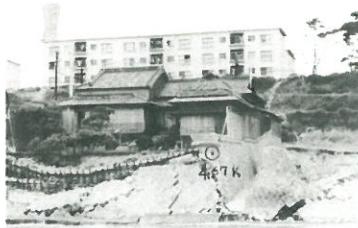
昭和33年頃に侵食によって崩落した木柵（西八木地先）
