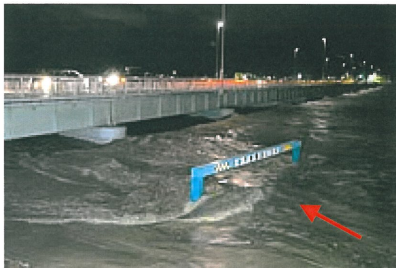
加古川橋(5.2k)付近の状況
