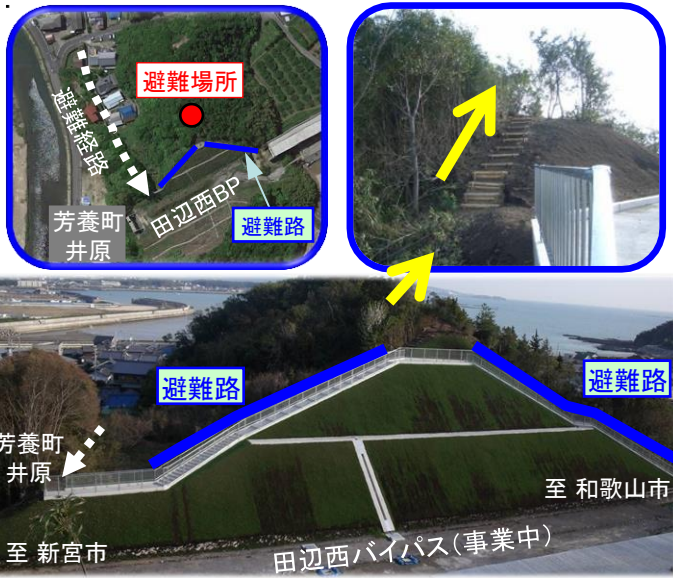
写真: 避難路の設置
