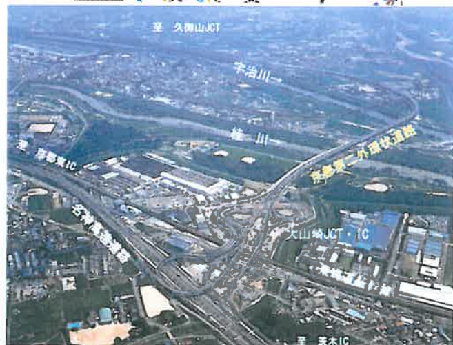
③ 大山崎JCT上空から久御山方面を望む
