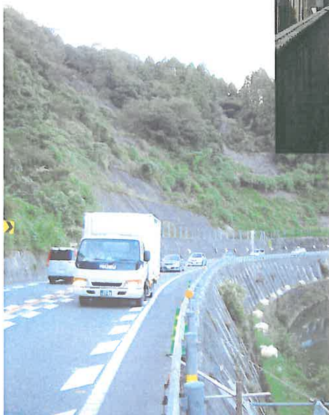
落石のおそれのある長大法面の下を走る現道
