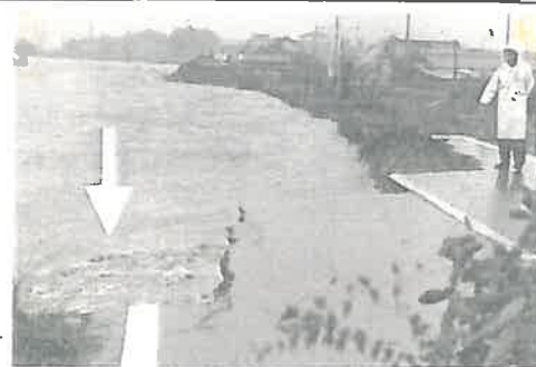
[栗栖川左岸 6.4km 付近 破堤状況]
