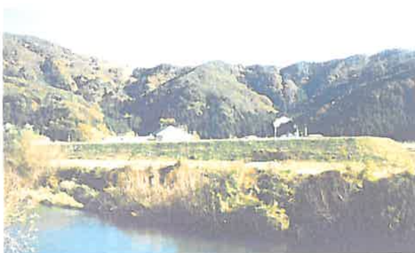
ほ場整備区域内での 先行盛土状況
