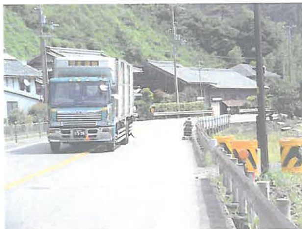
歩道未整備区間 (西浅井町)
