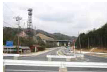
信楽道路(滋賀県施行区間)
