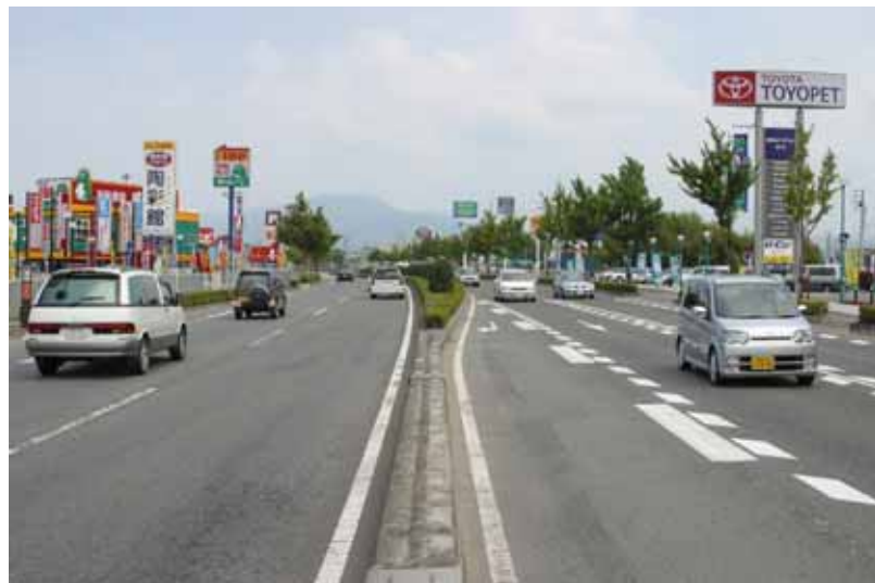
和歌山バイパス4車線化済み区間の状況 (岩出町畑毛付近)
