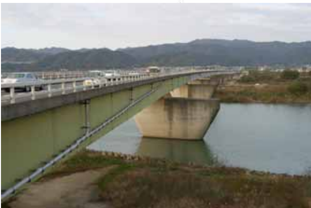
紀州大橋左岸側より (暫定2車供用区間：H16年3月撮影)
