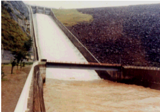
昭和 51 年の台風 17 号による洪水吐ゲートからの放流状況
