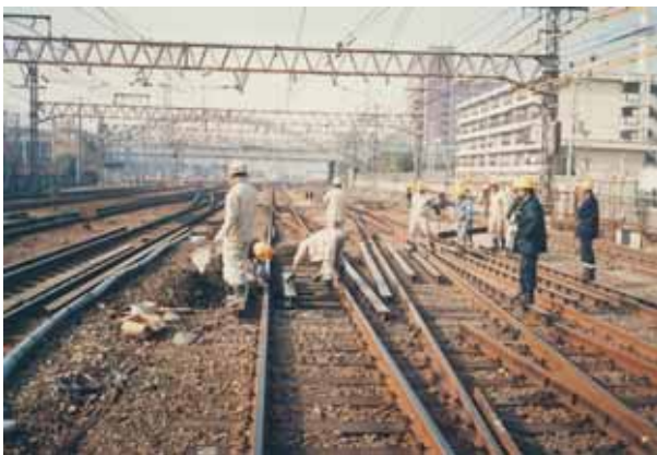
(鉄道直下での施工)
