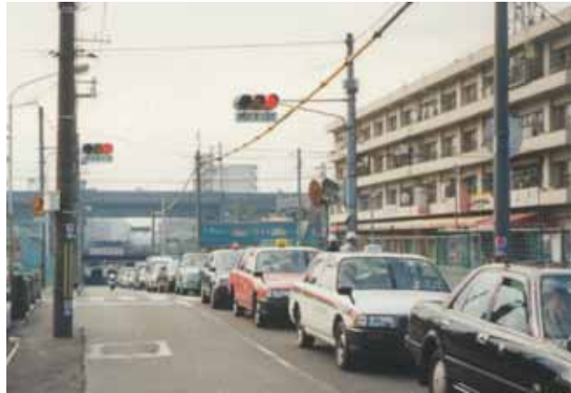
工事着工前の J R を越える部分付近の状況
