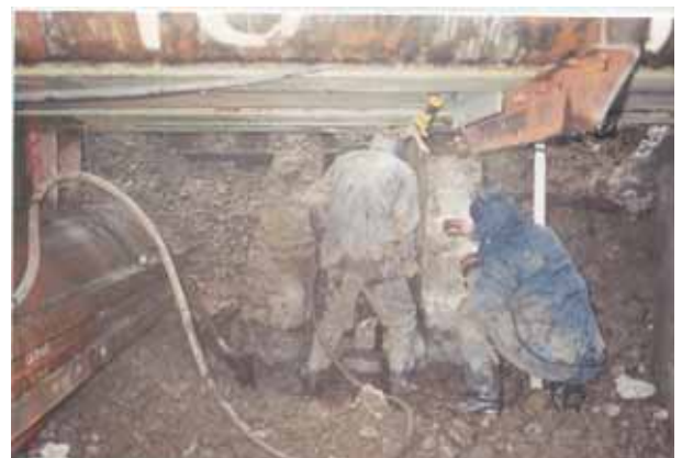
(人力による取壊し)
