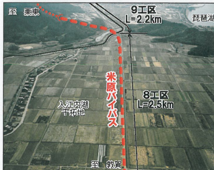
航空写真① (8・9工区)
