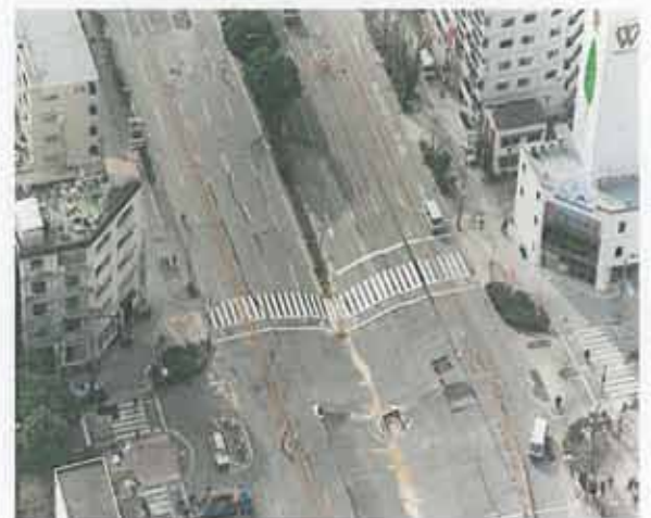
▲ 阪神淡路大震災で通行止となった道路
