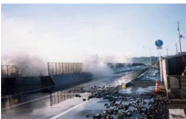
写真: 国道42号の越波状況
