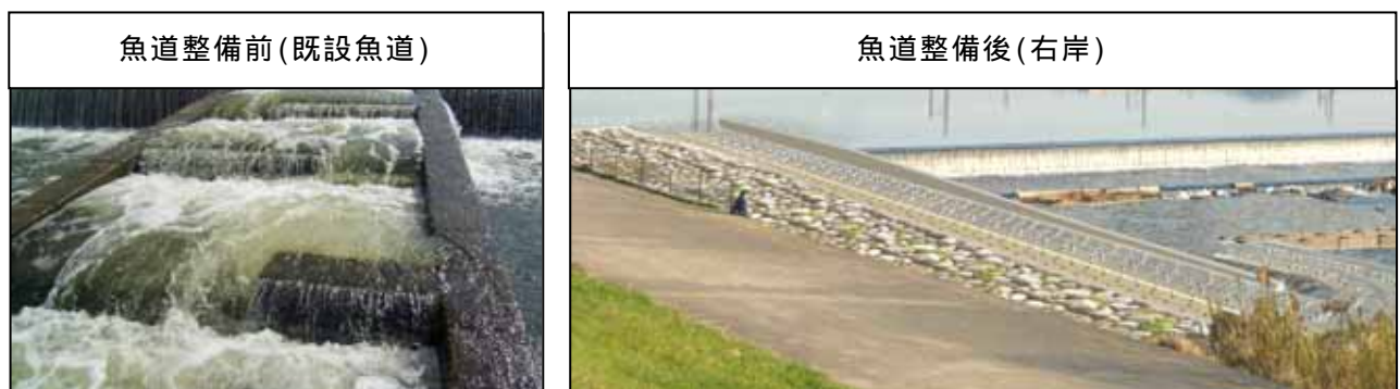
写真 3.4 魚道の整備前後の状況
