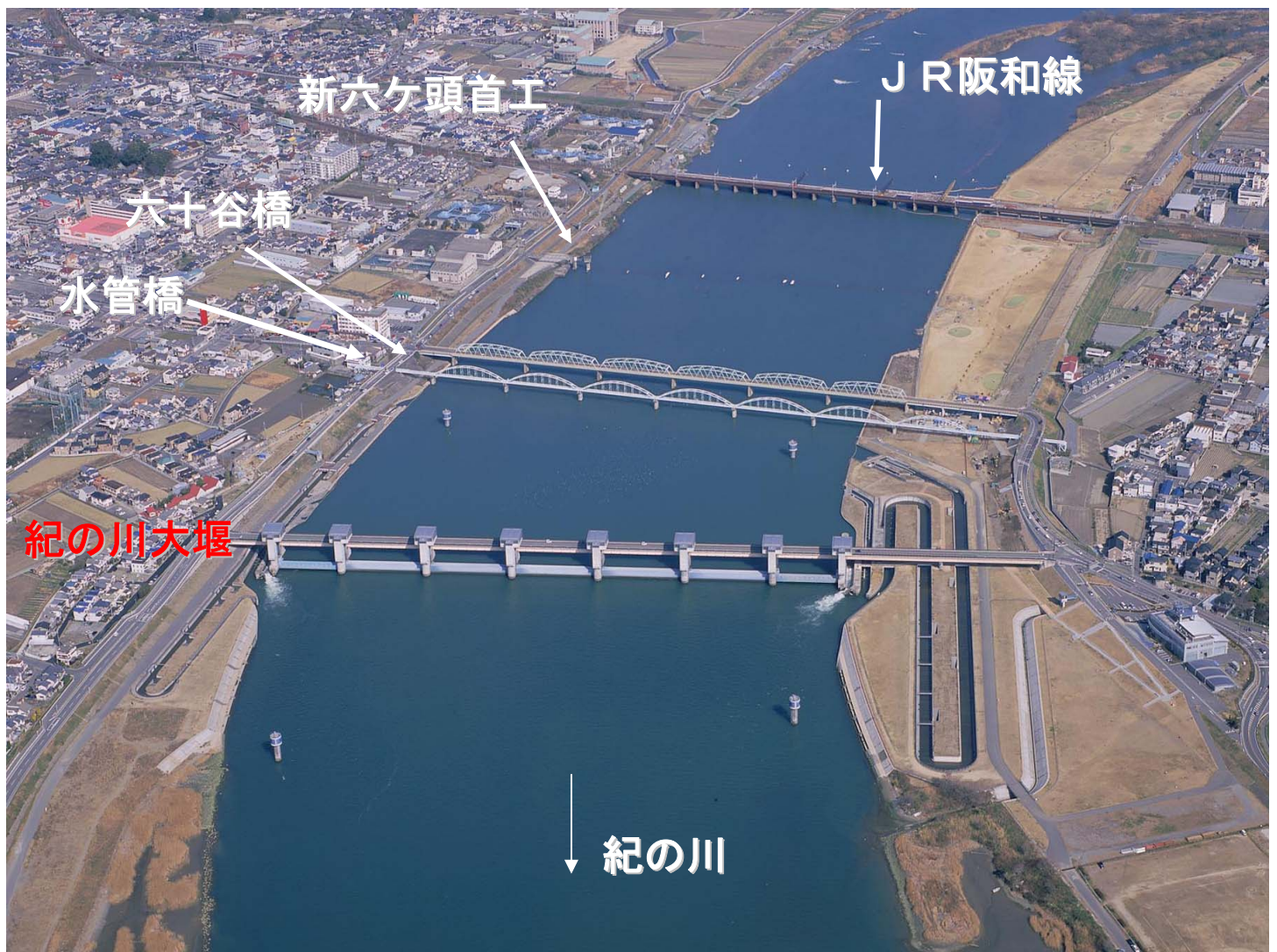
航空写真（紀の川大堰下流より撮影）平成18年3月撮影
