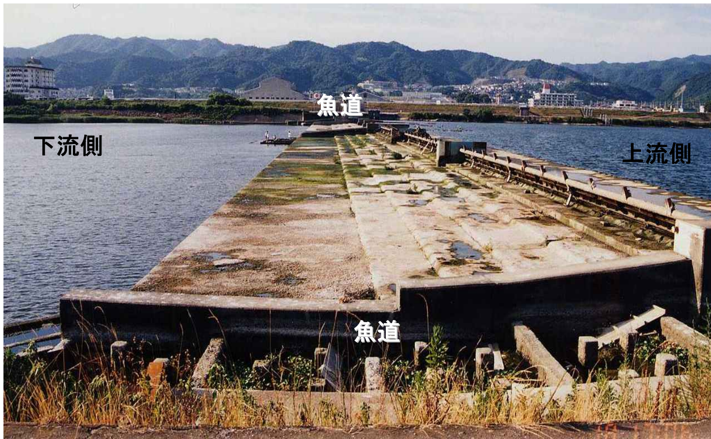
既存の新六ヶ頭首工 H6年撮影
