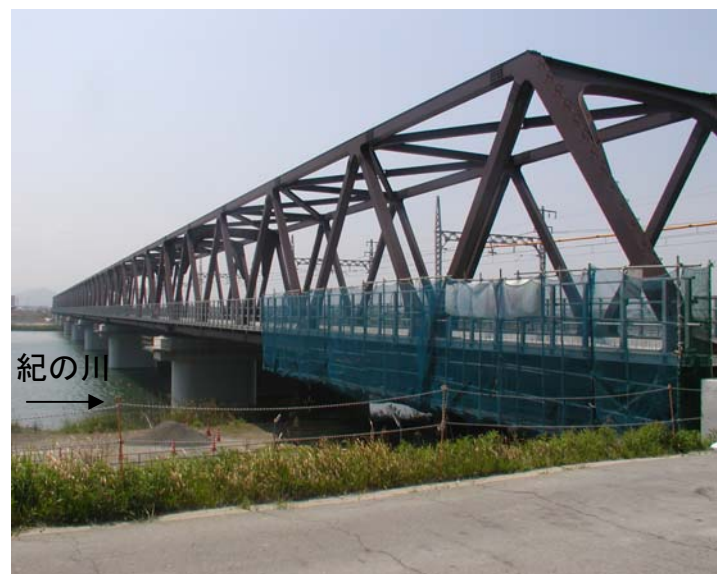
JR阪和線橋梁（新橋：手前と旧橋：奥） 平成20年4月撮影
