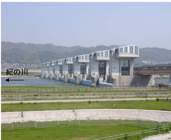
暫定運用中の紀の川大堰 平成20年4月撮影
