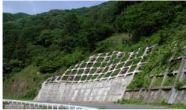
法面補修工事
