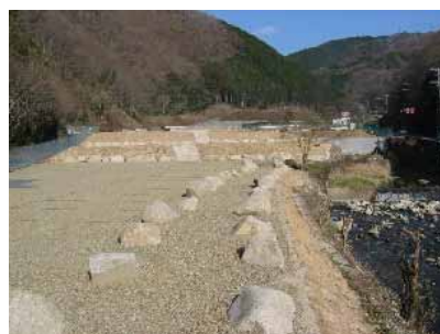
仮置残土の撤去後
