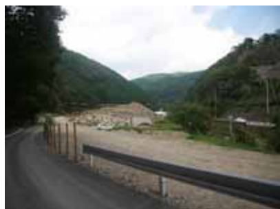
仮置残土の撤去前
