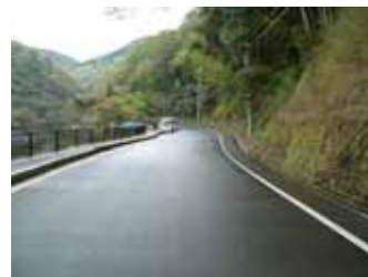
工事用道路整備状況(山王仙郷谷線)
