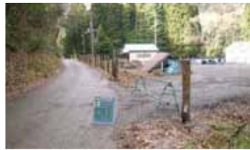
進入防止柵設置
