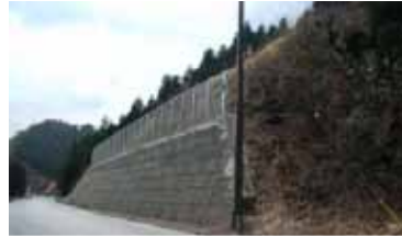
落石防護柵設置
