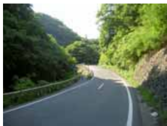
工事用道路整備状況(宇治志津川線)
