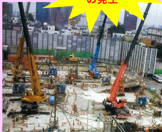
高圧噴射工法
