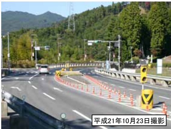
【写真②緊急車両のスムーズな追越が可能な十分な幅員(部分供用部)】
