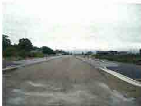
①改良工事 平成22年10月撮影
