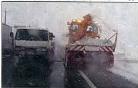
除雪作業状況(高島市マキノ町)
