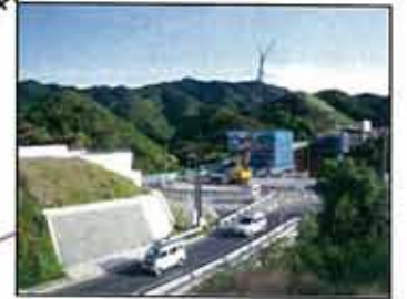
【写真①】南山中1号橋工事 (平成22年5月24日撮影)
