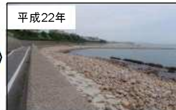
護岸工とレキ養浜により広がった現在の江井ヶ島付近の海岸
