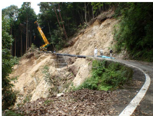
▲復旧工事の状況
