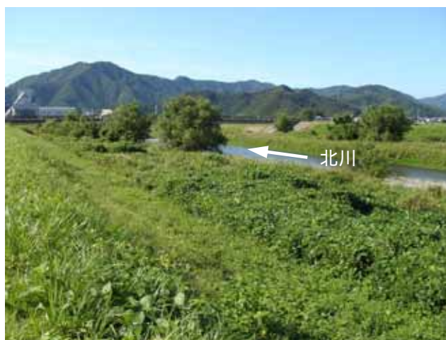
河道内樹木の伐採
