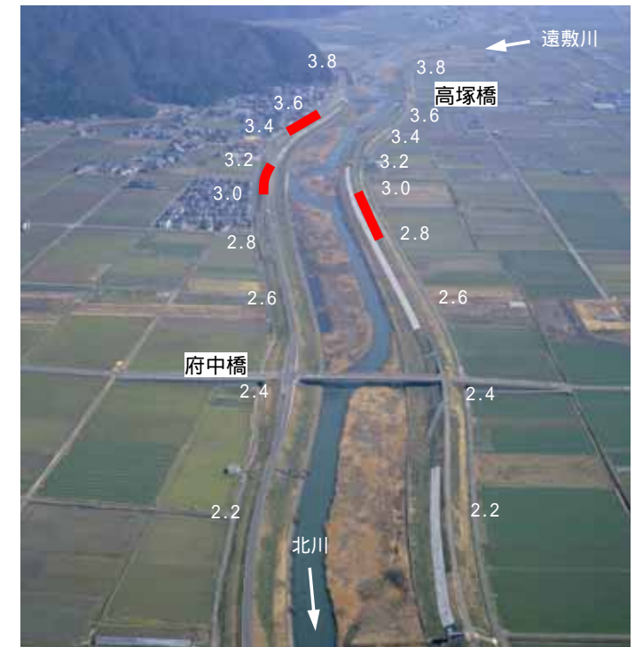
高塚地区 堤防拡築
