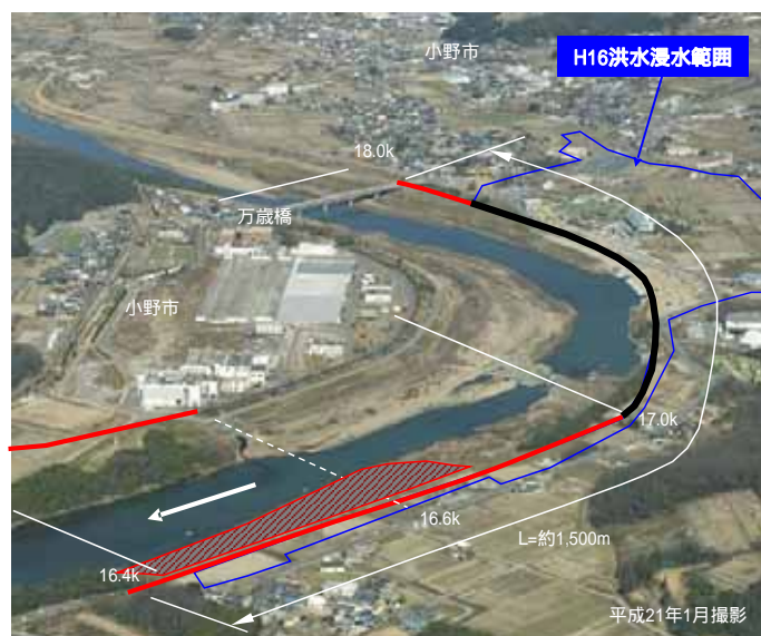
榎山・市場地区 築堤・河道掘削
