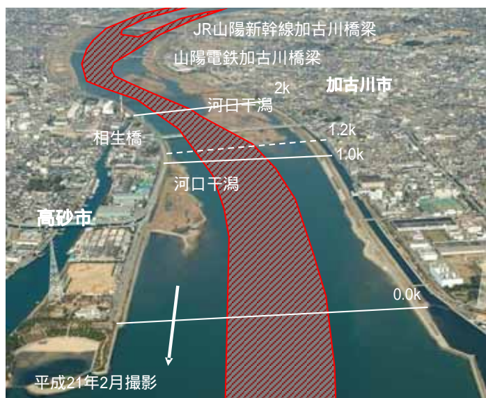
河口部 河道掘削
