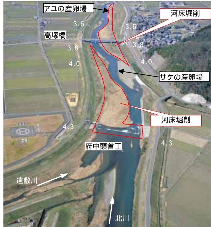
高塚地区 河道掘削・頭首工改築
