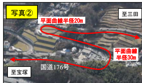
線形不良箇所 (東久保付近)
