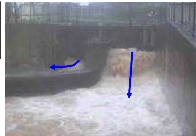
狐川分水施設導水箇所 (平成25年9月16日5:50頃)
