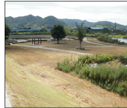
揖保川水辺プラザ (H7年度施工)
