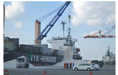
西浜第3岸壁における原塩の荷役状況 (平成23年5月撮影)
