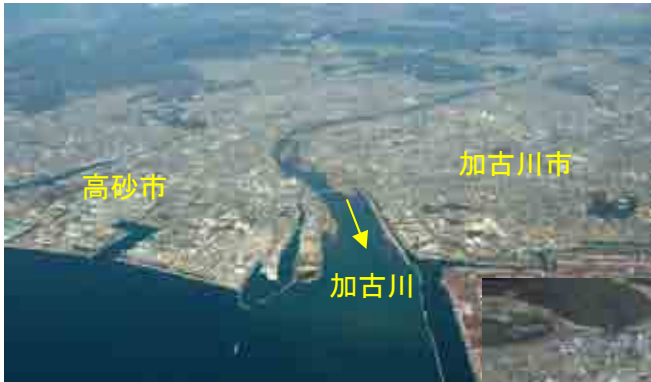
河口部・下流部の状況
