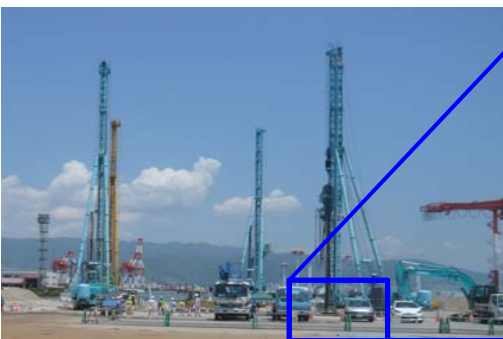
SCP工法による 液状化対策工事の施工状況
