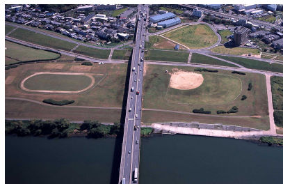
沿川7市町が広域避難場所に指定 (写真は太間地区)
