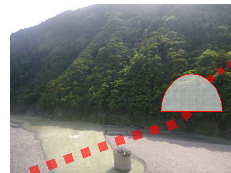
写真① 豆市トンネル(折立出入口から南望む) (撮影日: H27年5月20日(水))
