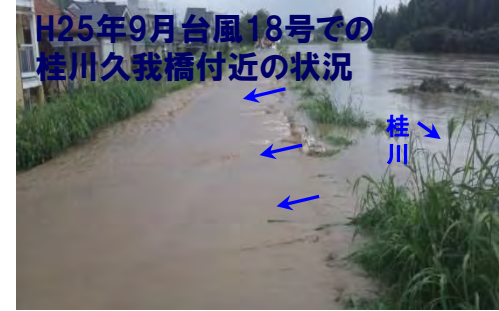
H25年9月台風18号での 桂川久我橋付近の状況 桂川の久我橋下流右岸で堤防を乗り越える洪水
