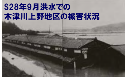
S28年9月洪水での 木津川上野地区の被害状況 戦後最大洪水であり、上野地区及び名張地区で甚大な被害が発生
