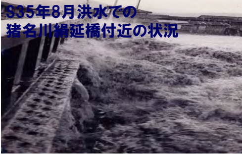
S35年8月洪水での 猪名川綿延橋付近の状況 伊丹市口酒井地区で堤防が30mにわたって決壊し、多数の家屋に床上浸水の被害
