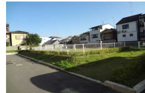
浸水への特別な対策 (気象観測機器設置部の嵩上げ)
