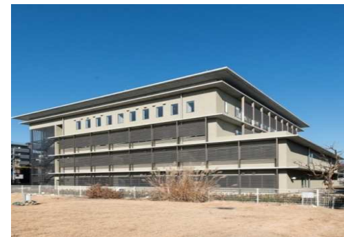
京都地方合同庁舎の整備状況
