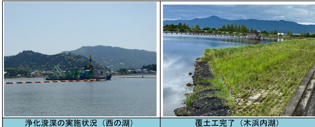
浄化浚渫の実施状況（西の湖）
