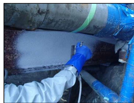
剥離剤工法の施工
