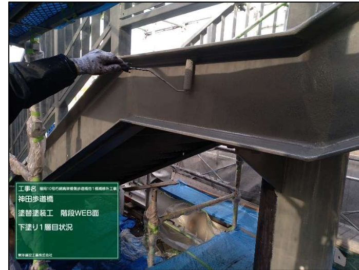
②下塗り工(1層目):アースコート防錆塗料
