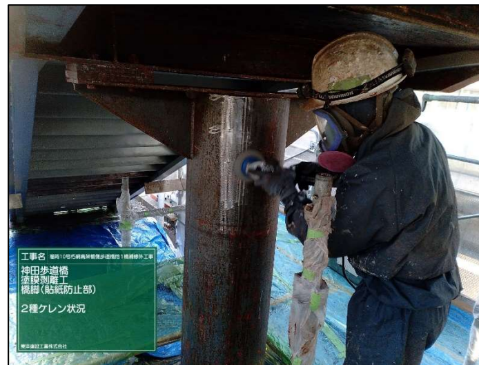
素地調整工:吸塵式サンダーケレン
