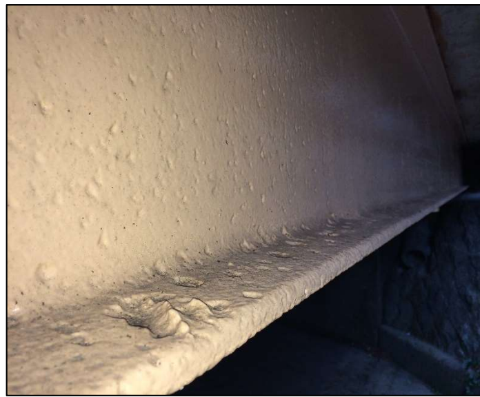
激しい孔食箇所施工後の現状
