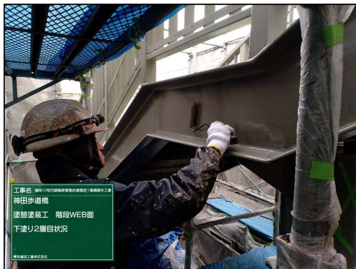
③下塗り工(2層目):アースコート防錆塗料
