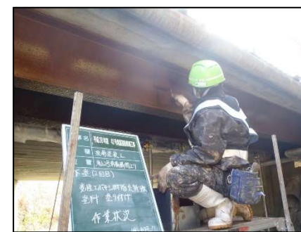
アースコートの施工
