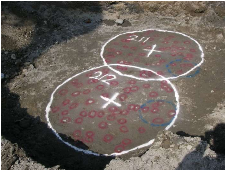
既製杭破砕出来形状況
