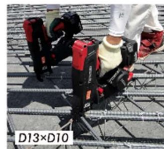
高速度路床版の鉄筋結束作業も2台同時使用でスピーディーに。
