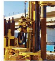
【ロッド繋ぎ完了】
